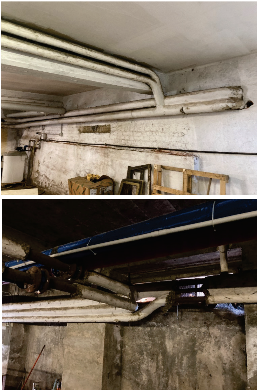
Figura 8 Sistema di distribuzione al piano seminterrato
