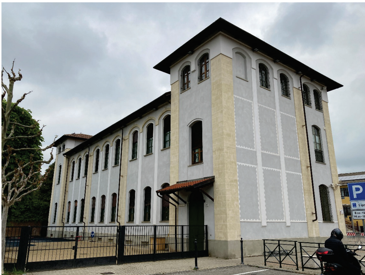
Figura 3 Porzione di fabbricato di antico impianto
