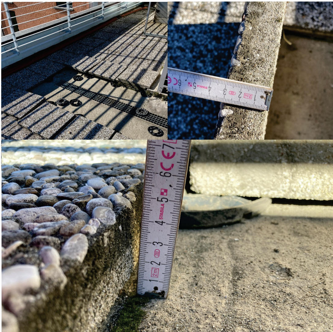
Figura 1 Sistema pavimento galleggiante in copertura piana
