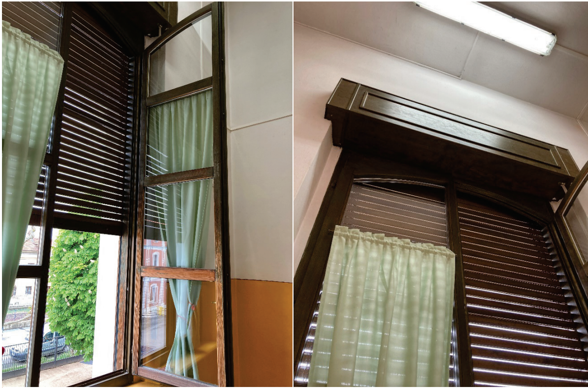
Figura 4 Infisso esterno con telaio in legno, vetro doppio e tapparella in legno
