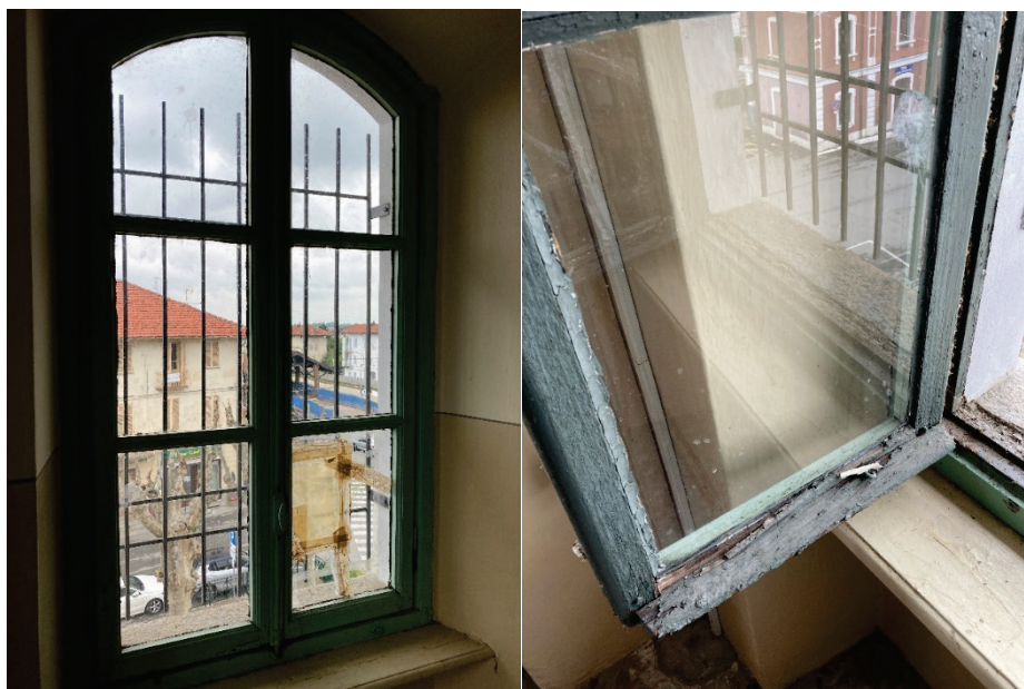
Figura 5 Infisso esterno originale con telaio in legno e vetro semplice
