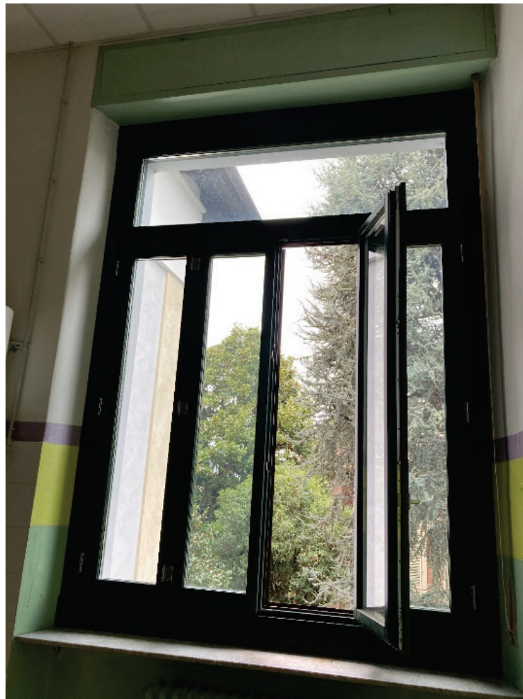
Figura 6 Infisso esterno in legno e vetro camera di recente sostituzione
