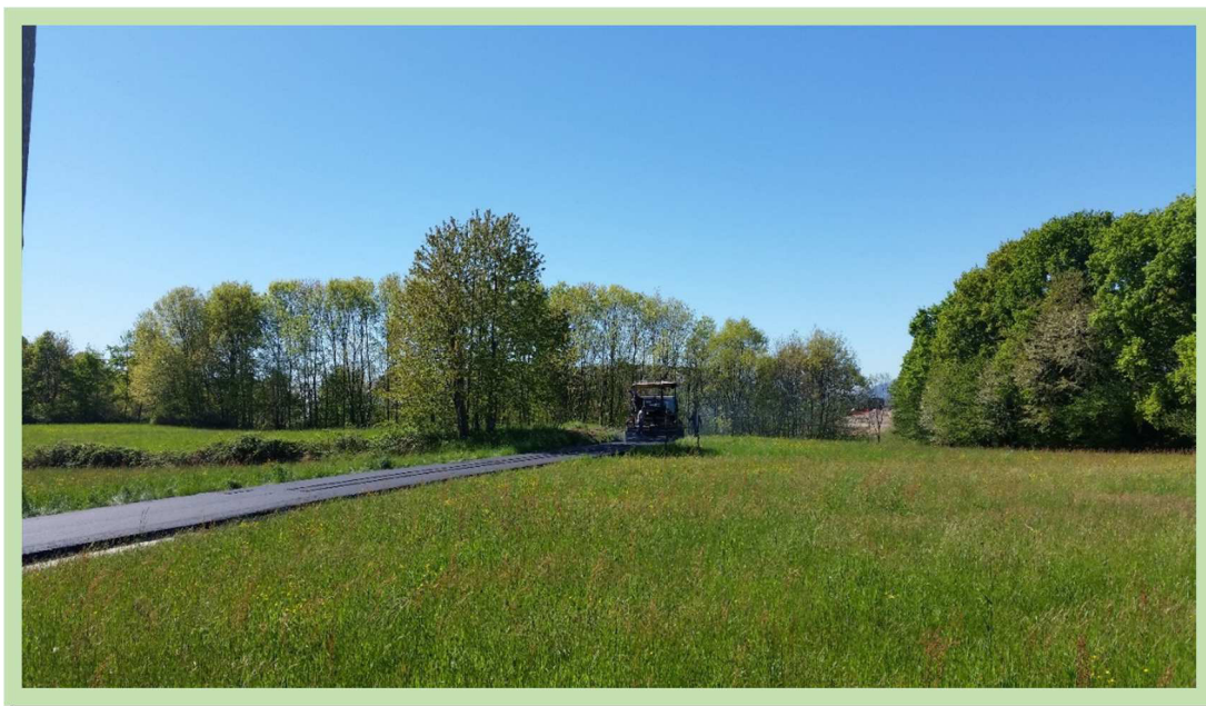
Opere di compensazione Lotto 3 – asfaltatura della via Vigna
