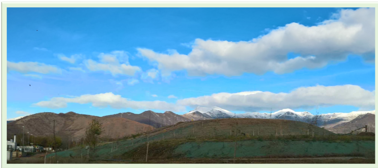
Vista del Lotto 2 al termine delle operazioni di ricoprimento finale
